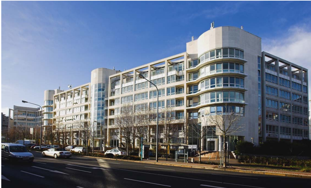
Objekt Darmstädter Landstraße 180-186 in Frankfurt. Bild: Colliers International
